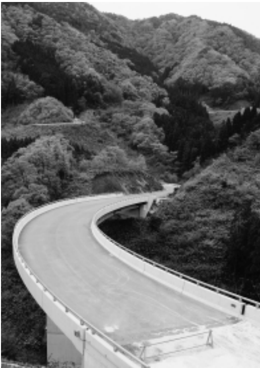
整備が進む一般県道日野溝口線
