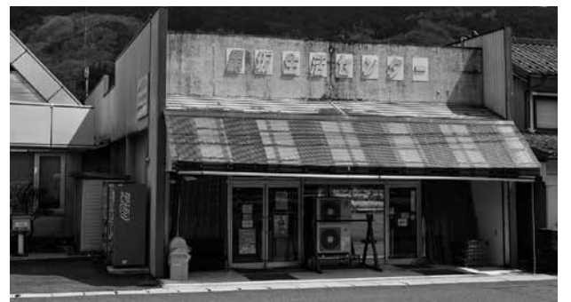
黒坂店舗 屋根の修繕
