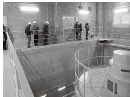
発電所の心臓部「タービン室」
