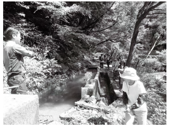
再稼働した根雨発電所水路見学会
