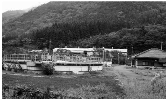
公共下水道の終末施設（舟場）
