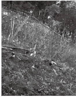
斜面の崩落対策
