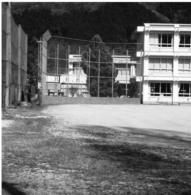
義務教育学校の建設予定地(根雨小学校グラウンド)
