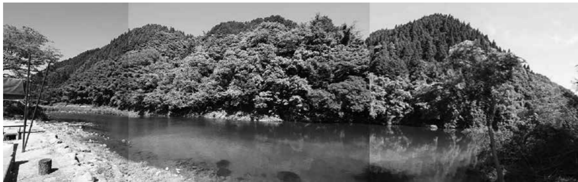
町道下黒坂線の工事予定地（舟場周辺）
