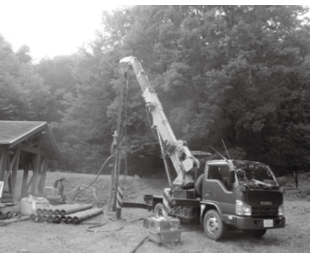
鶴の池キャンプ場のボーリング調査
