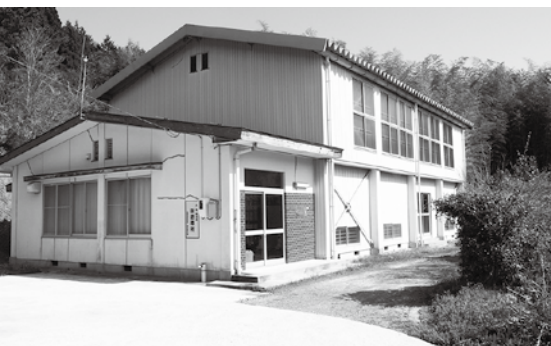
久住地区集会所(黒坂小学校旧久住分校体育館)
