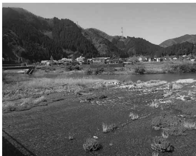
日野川左岸、野田橋下流の現場
