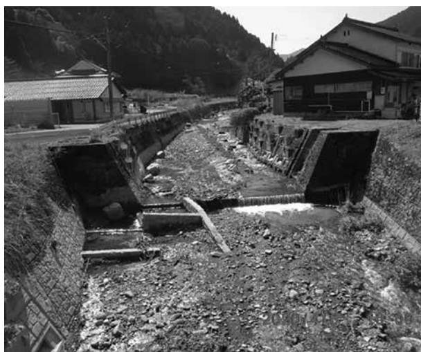
本郷地区、整備された小川尻川
