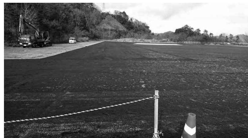
滝山ヘリポート工事中
