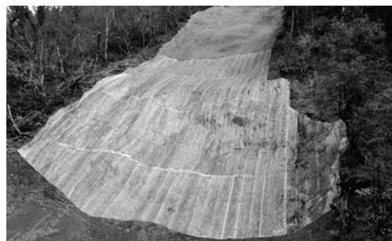
斜面崩壊復旧現場（野谷）
