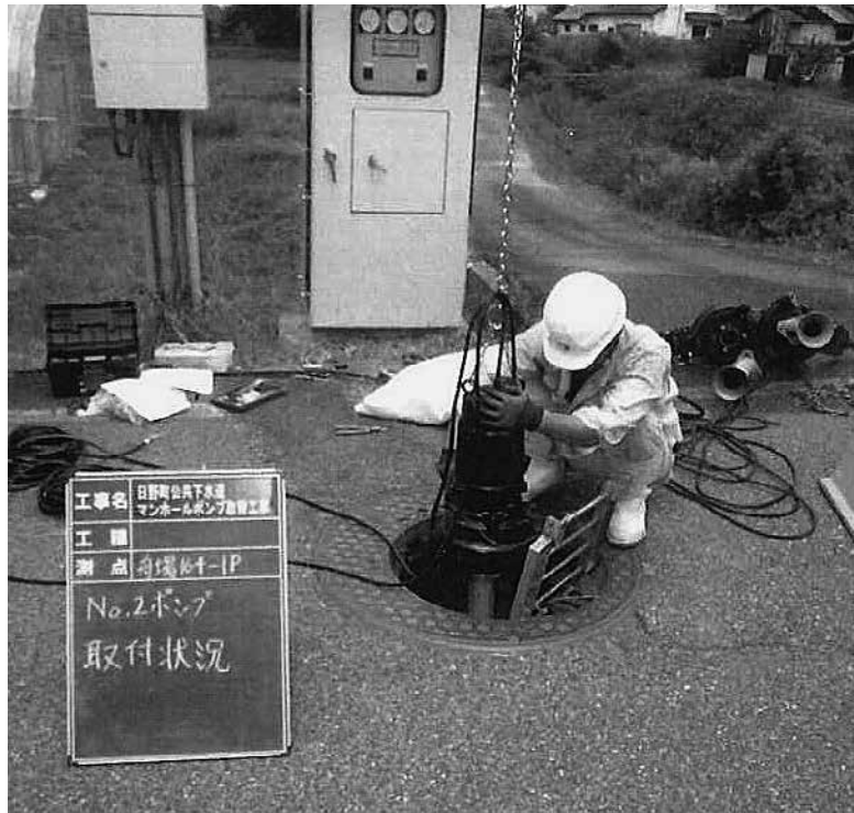
マンホール点検作業
