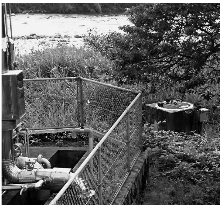
根雨地区浄水場取水ピット
