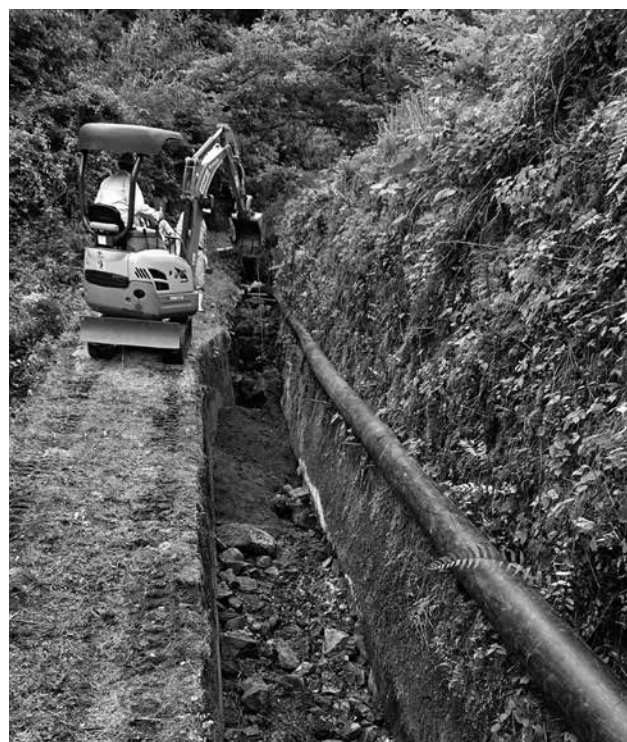
オオサコ谷川改修工事
