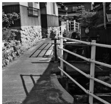
オオサコ谷川の水害工事
