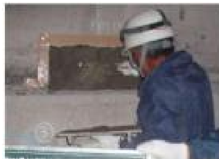
写真 6.2 断面修復工施工状況例
