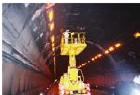
写真 5-4 レーダ-探査状況（例）
