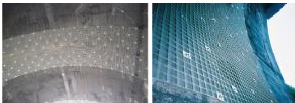
写真 6.1 FRP メッシュ設置状況例
