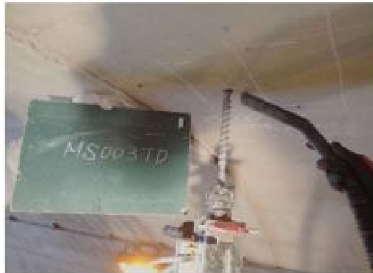
写真 5-6 ドリル削孔状況（例）
