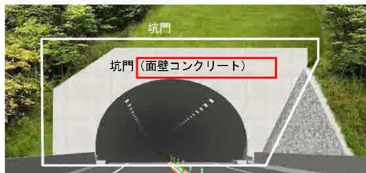
図3.2 トンネル本体工点検箇所
