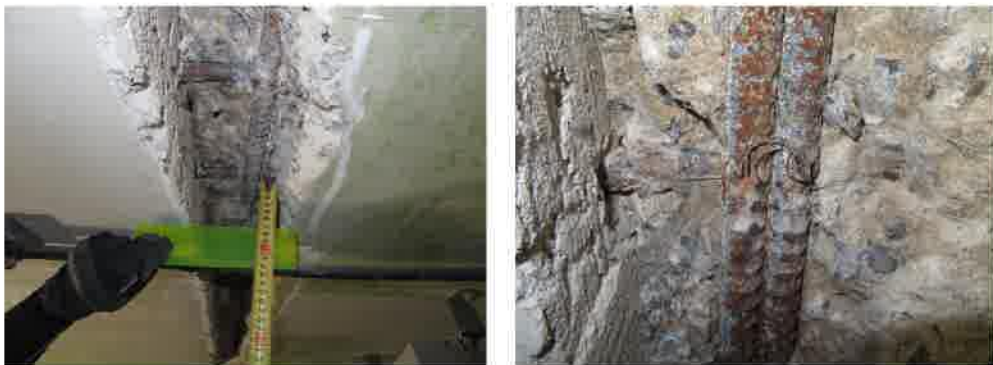
写真 5.9 はつり面と鉄筋
