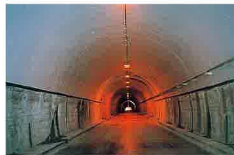
写真 6.3 炭素繊維シート設置状況例
