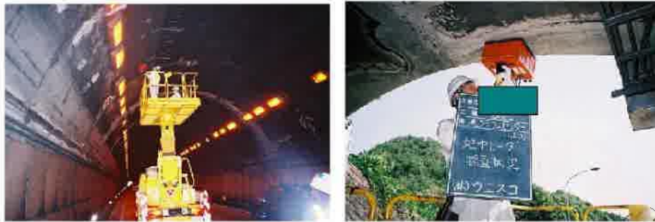
写真 5-4 レーダ探査状況（例）
