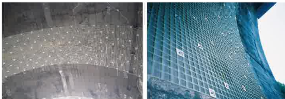
写真 6.1 FRPメッシュ設置状況例
