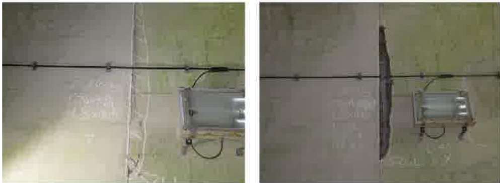
写真 5.8 モルタルのブロック化 左：除去前 右：除去後 S020（Ⅳ→Ⅲ判定）
