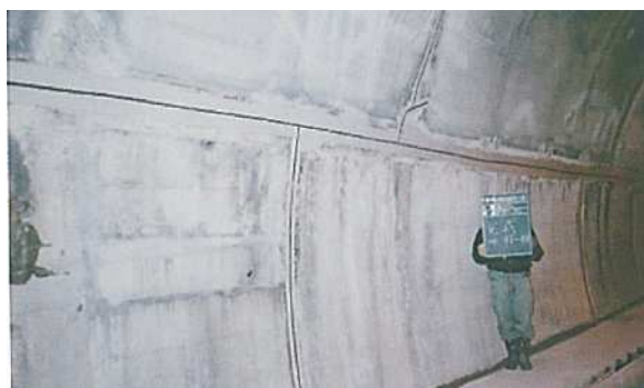
写真 6.3 溝切り工施工状況例
