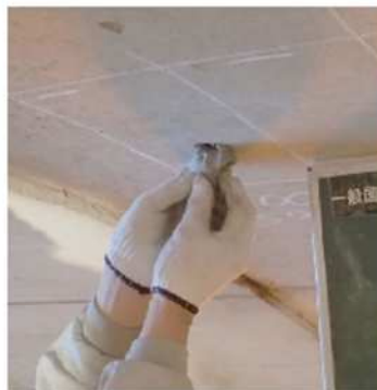
写真 5-7 閉塞状況（無収縮モルタル）
