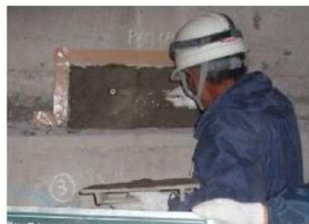
写真 6.2 断面修復工施工状況例
