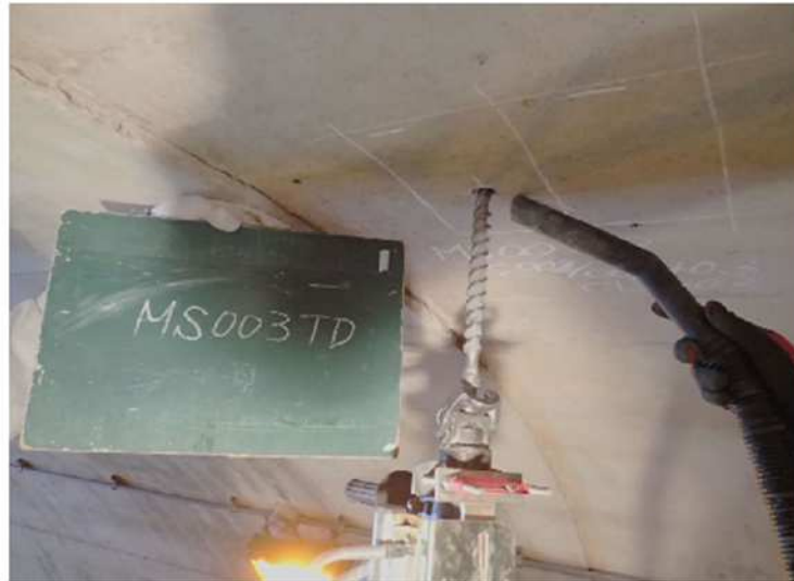
写真 5-6 ドリル削孔状況（例）
