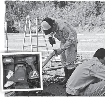
便利なインパクトドライバー。ビットを変えれば、ドライバーとして使えたり、六角ボルトを締めたりもできます。ドリルをつければ金属、木材、コンクリートにも穴をあけたりできる優れもの。普段の活動でも重宝しています。
