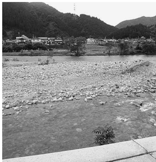
板井原川、日野川合流地点の堆積土砂
