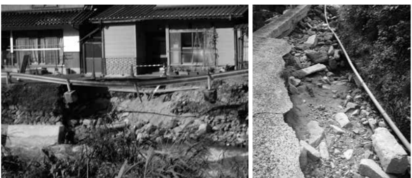
護岸が崩壊した金持地区の町道
