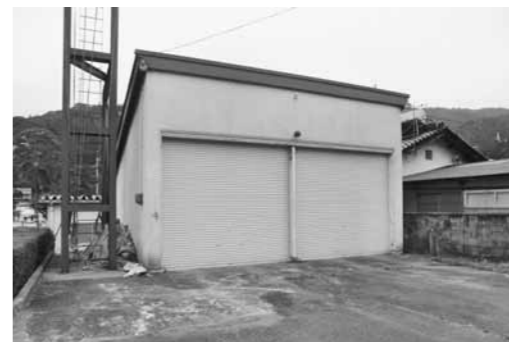
黒坂消防車庫にトイレなどを設置
