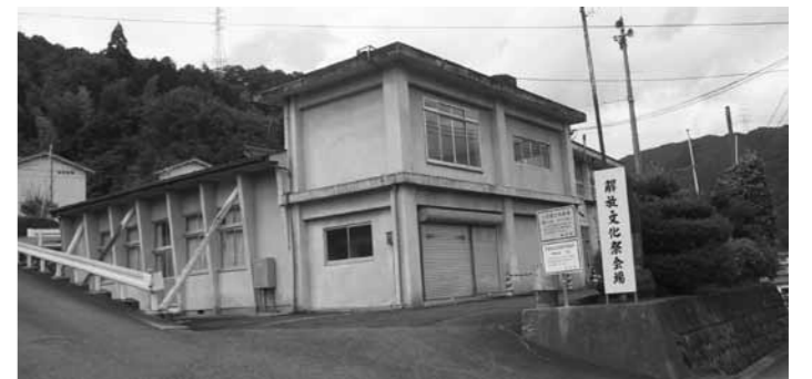
改修が行われる下榎隣保館
