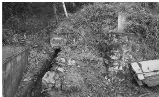
根雨6区権現谷溪流水路の状況
