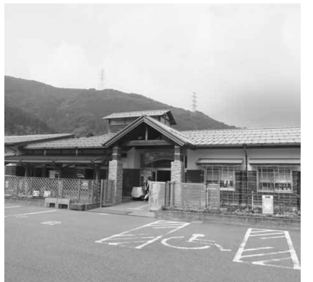
ひのっこ保育所の空調設備修繕
