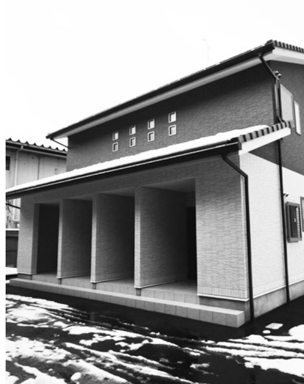
▲若者向け町営住宅の建設
