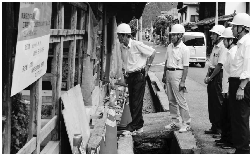
町公舎改修工事を調査する常任委員会委員
