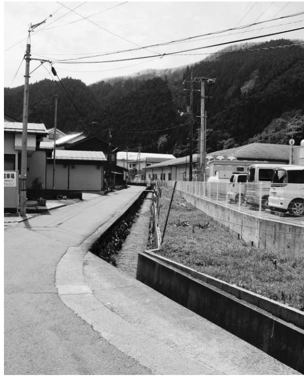
町道西側線の工事始まる
