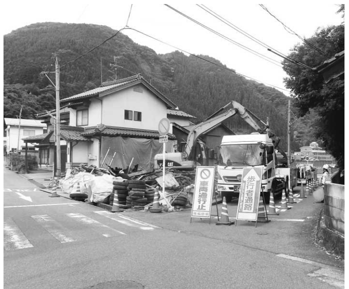
町道天王線拡幅のため家屋の解体工事
