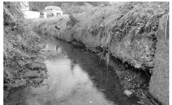
改修される本郷井手（下菅地区）
