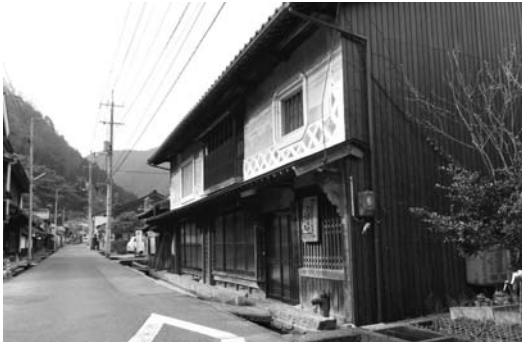
改修される日野町公舎
