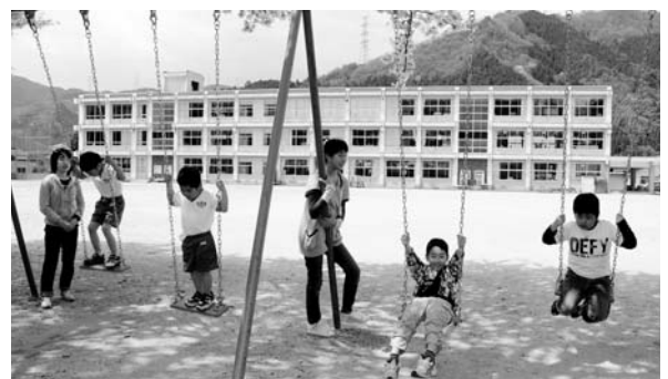
耐震化工事をする根雨小学校
