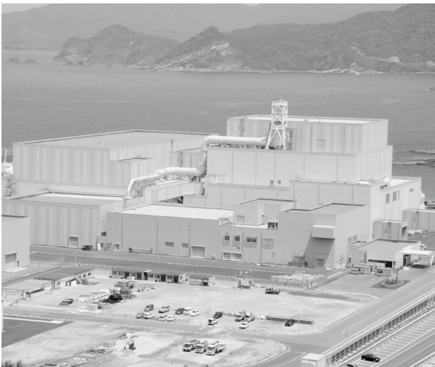
島根原子力発電所
