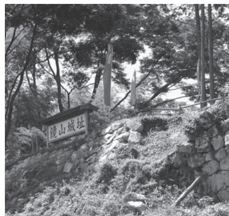
地元有志の手で現れた石垣の一部
