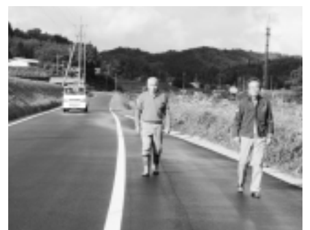
改修された町道久住線
