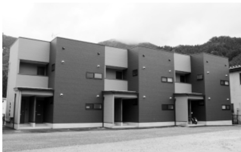
完成した職員住宅（日野病院）
