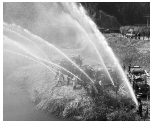
江府消防署と合同で一斉放水
