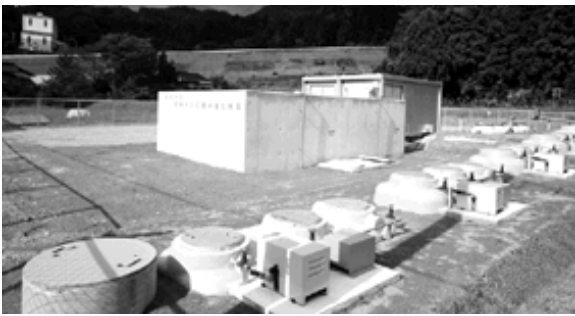
排水処理場に隣接する汚泥消滅化施設
