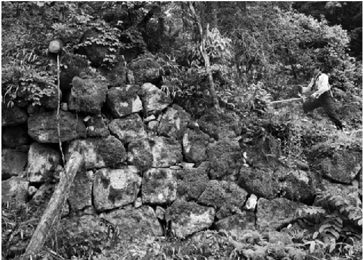
数か月の作業のすえ姿を現した黒坂城の石垣。黒坂駅からも確認できる
