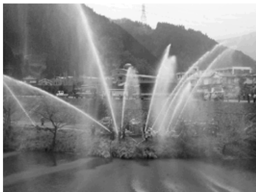
サイレンの音とともに一斉に放水
