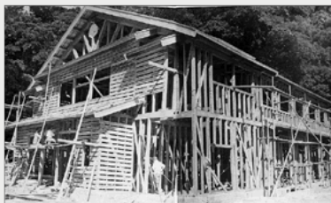
建築中の根雨公会堂
