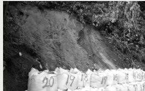
いたるところで土砂災害が発生
