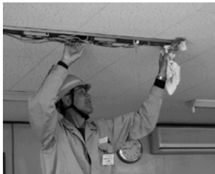
蛍光灯を外してクリーニング
