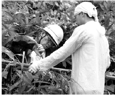
雨に濡れながら防護柵を補修する参加者
