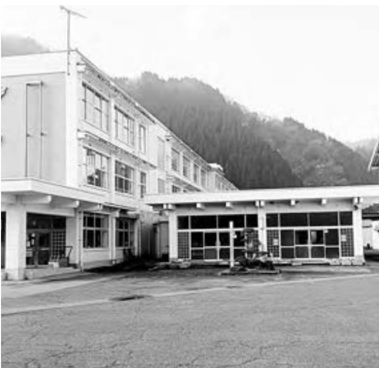
解体される根雨小学校昇降口
