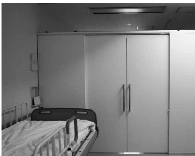
日野病院3階廊下を仕切り、陰圧室が完成
