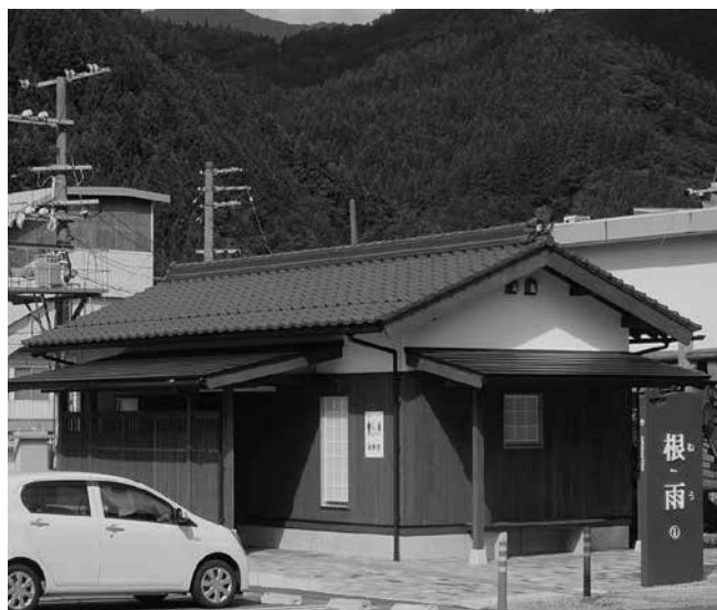
新設の駅前トイレは全て洋式で評判が良い
