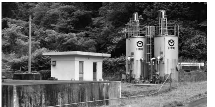
黒坂地区簡易水道配水施設、一層の節水を
