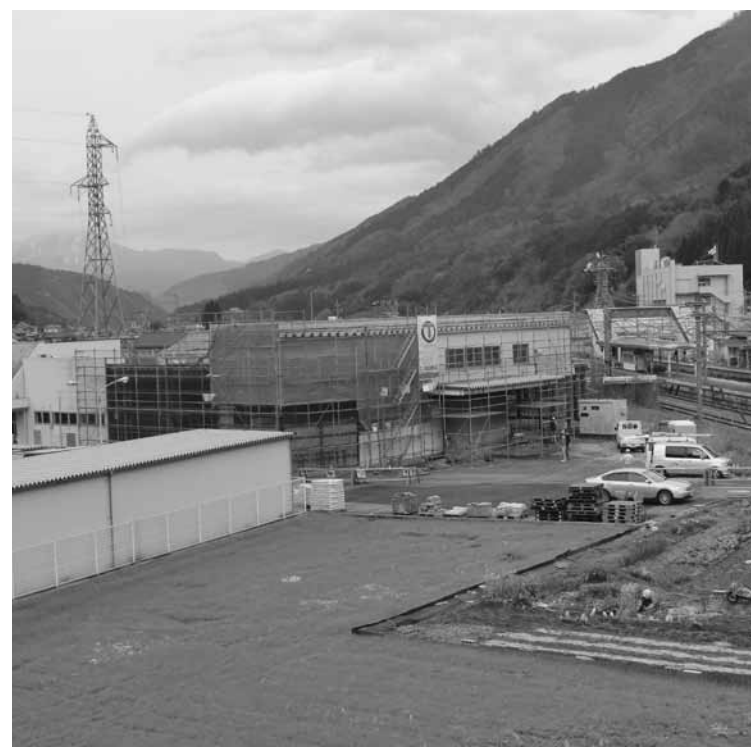
4月から工事が始まった元サンプラザ（外壁工事着工）
