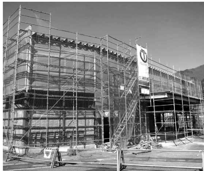
外壁工事中のセレモニーゾーン
