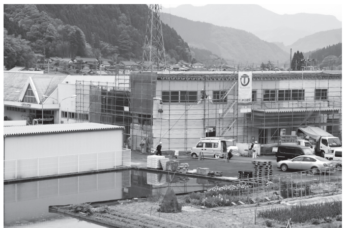
▲外壁がシートに覆われ工事が着々と進む
