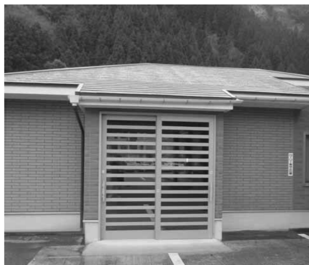
日野病院正面玄関入口左側の建屋「発熱外来棟」
