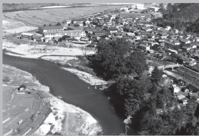
集中豪雨で流失した野田橋(昭和40年)
