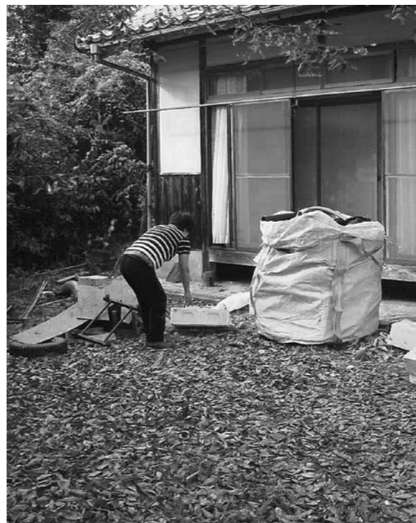
片付け中の空き家
