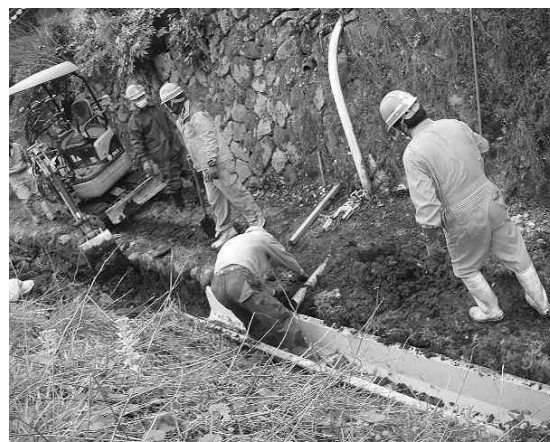
中山間地水路改修作業
