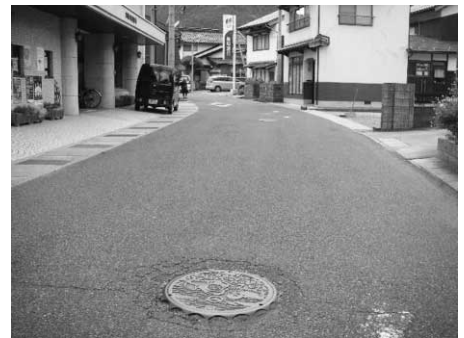
修繕される町道
