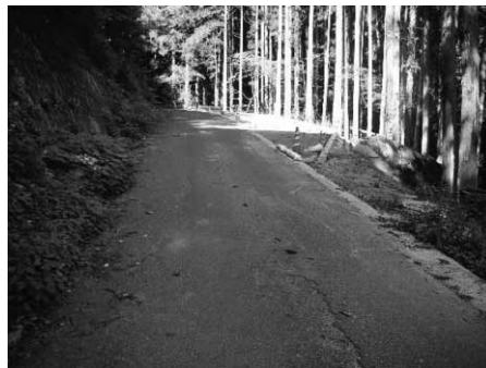
改修中の町道黒谷線
