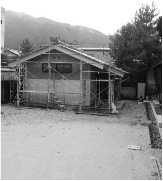
新築中の歴史民俗資料館分館 (町公舎裏)
