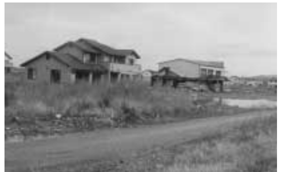
原野化した被災住宅周辺
