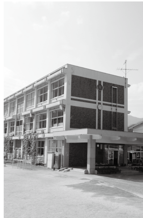
耐震化が行われる根雨小学校校舎
