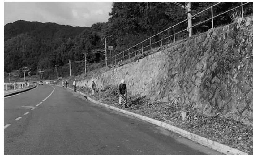
町道の草刈作業（緊急雇用）
