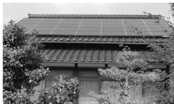
太陽光発電（ソーラーパネル設置住宅）
