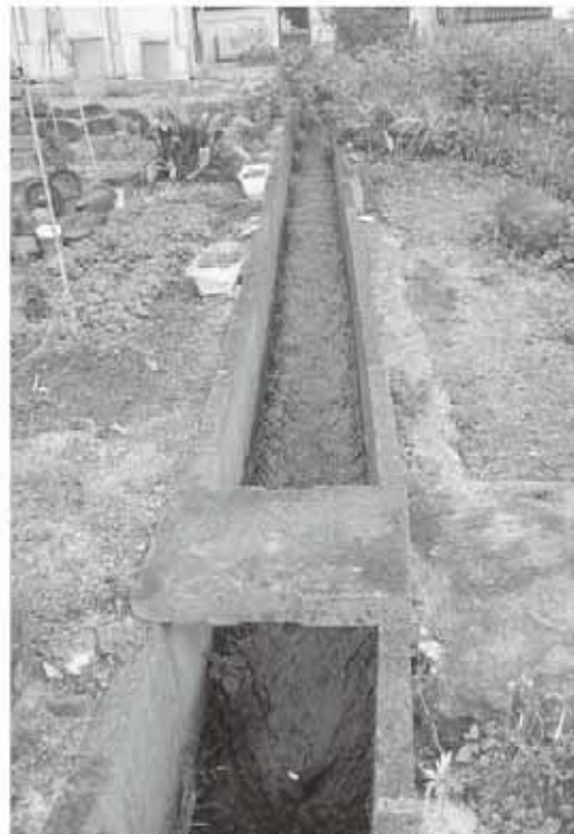
改修が急がれる水路対策
