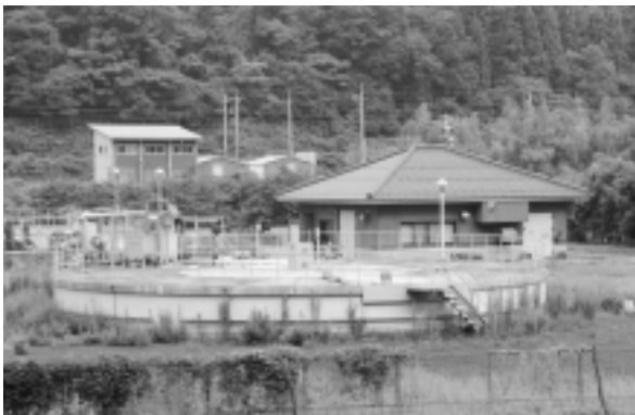
修繕が必要な日野中央浄化センター
