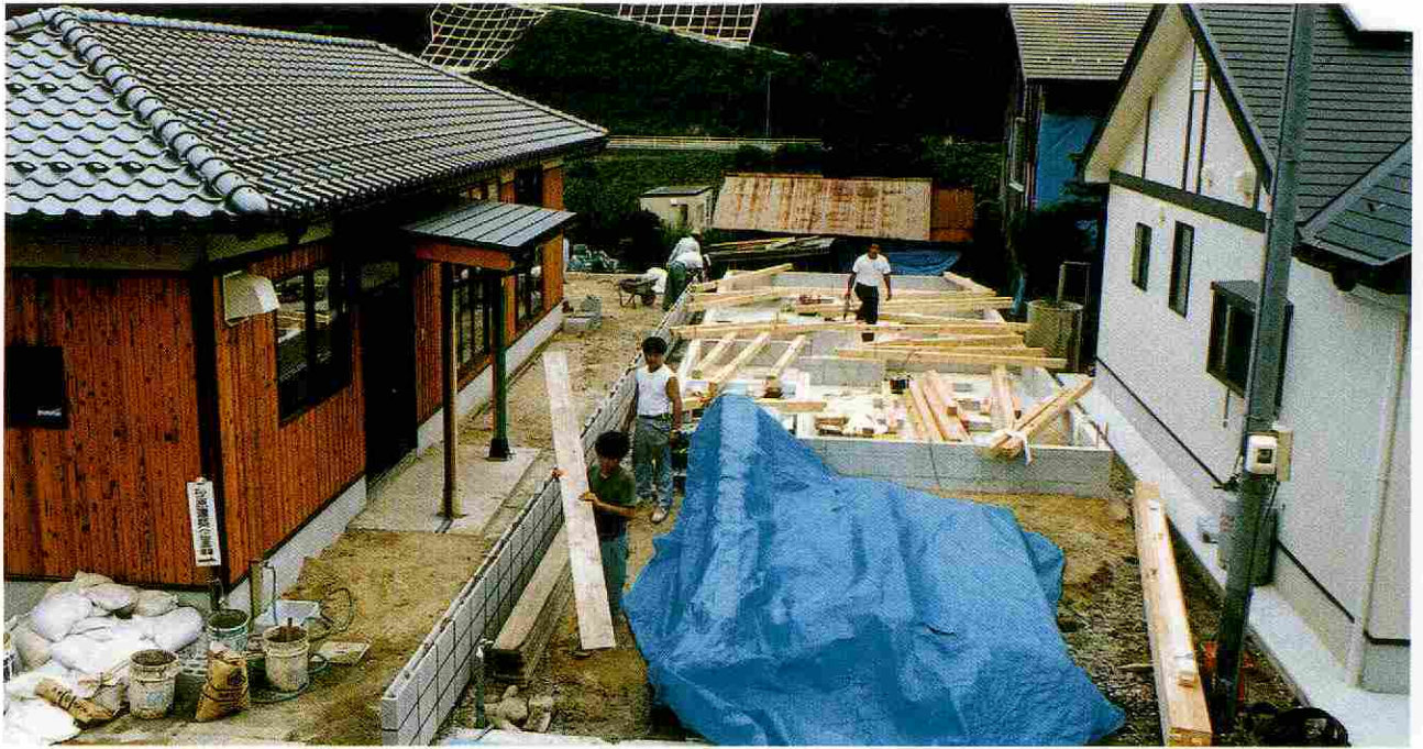
一日も早い復興をめざして、住宅の新築、修繕が急ピッチで進められている（黒坂地内）
