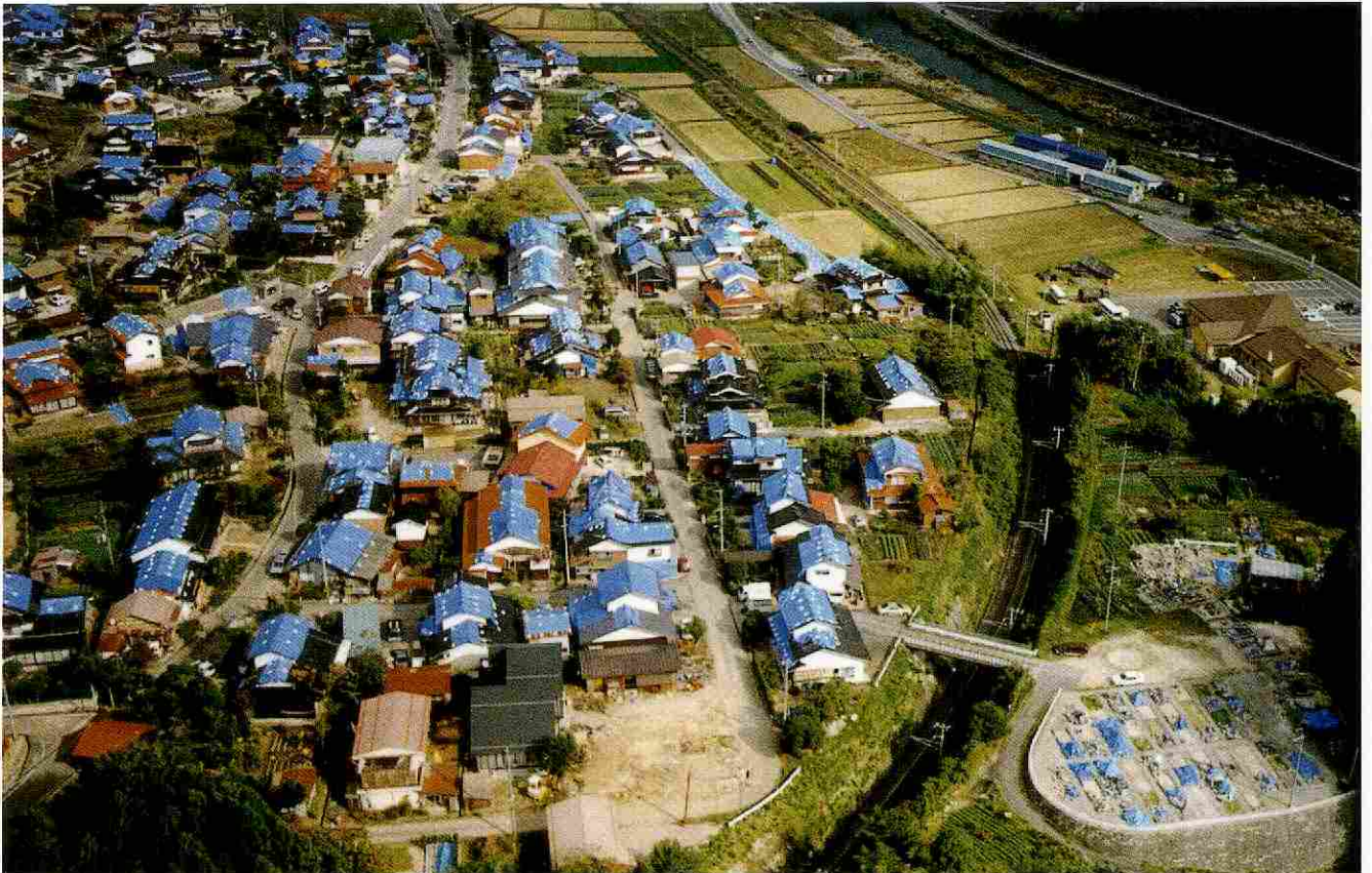
ブルーシートの屋根が並ぶ下榎地区（地震による被害は日野町全戸に） （写真：岡山県・堀家純一氏、平成12年10月撮影）
